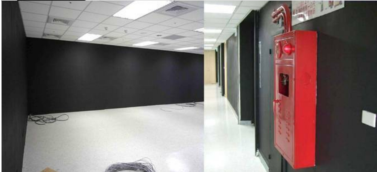
Θωράκιση στούντιο ηχογράφησης
